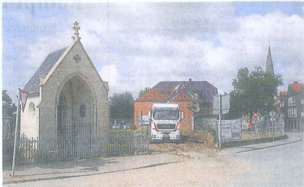
Im Herzen von Amelsbüren ist gestern mit dem Bau des geplanten Mehrfamilienhauses der Volksbank Amelsbüren begonnen worden.
