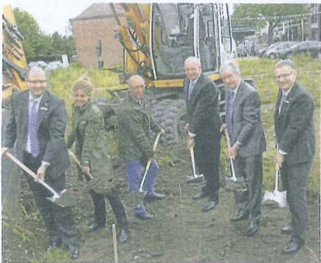
Am Mittwoch waren beim ersten Spatenstich (v.l.) Martin Lauhoff (Vorstand), Gerda Holstein (Architektin), Paul-Heinz Zimmermann (Architekt), Josef Woermann (Aufsichtsrat), Paul Steverding (Aufsichtsratsvorsitzender) und Jürgen Webner (Vorstand) dabei.
